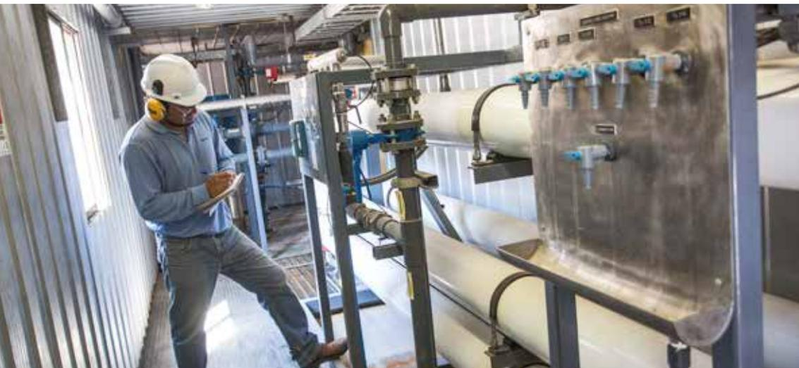
Planta de purificación de agua mediante osmosis inversa para producción de agua potable en Diego de Almagro, Aguas Chañar.
