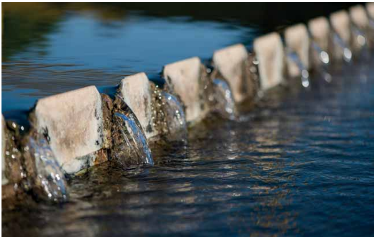
Essbio, planta de agua potable La Mochita
