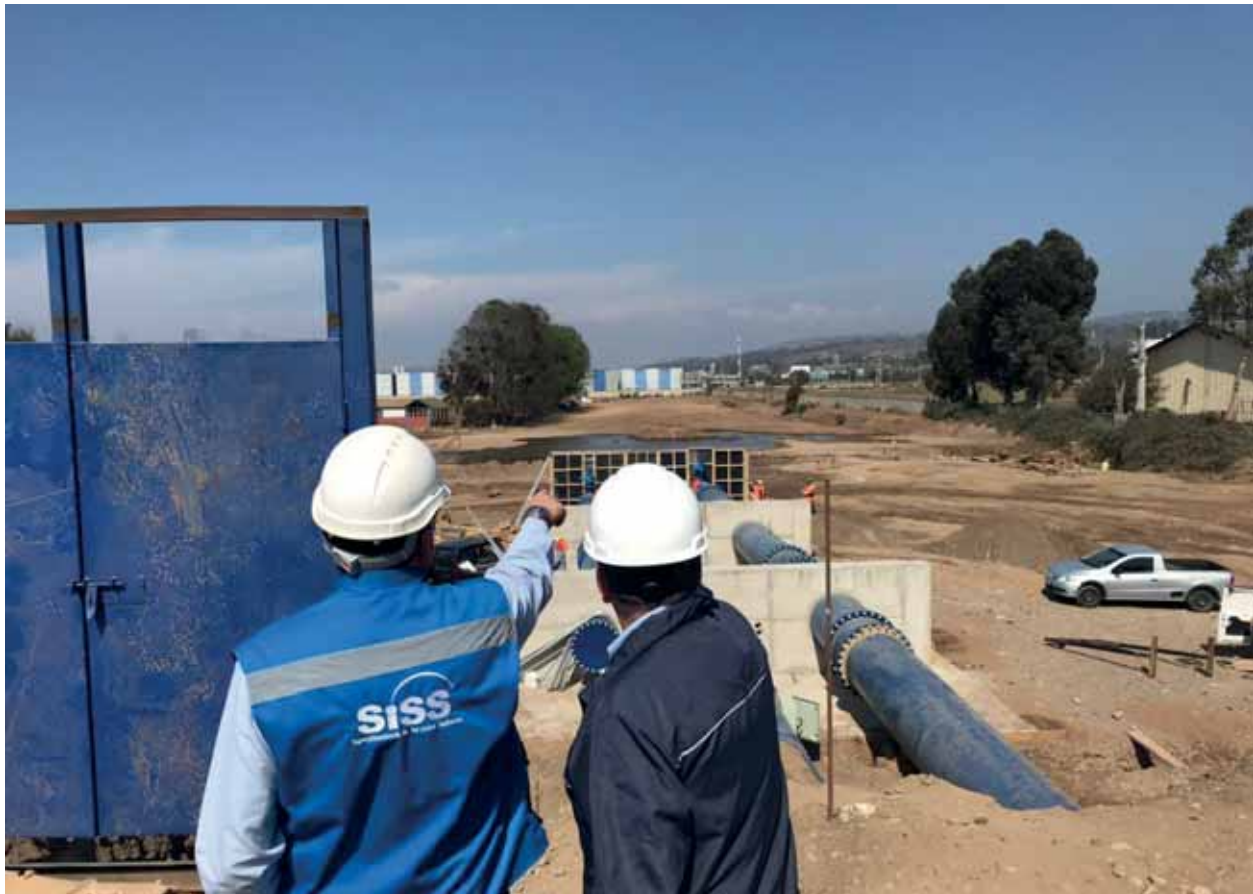
Obras de conexión en la Región de Valparaíso, Los Aromos - Concón
