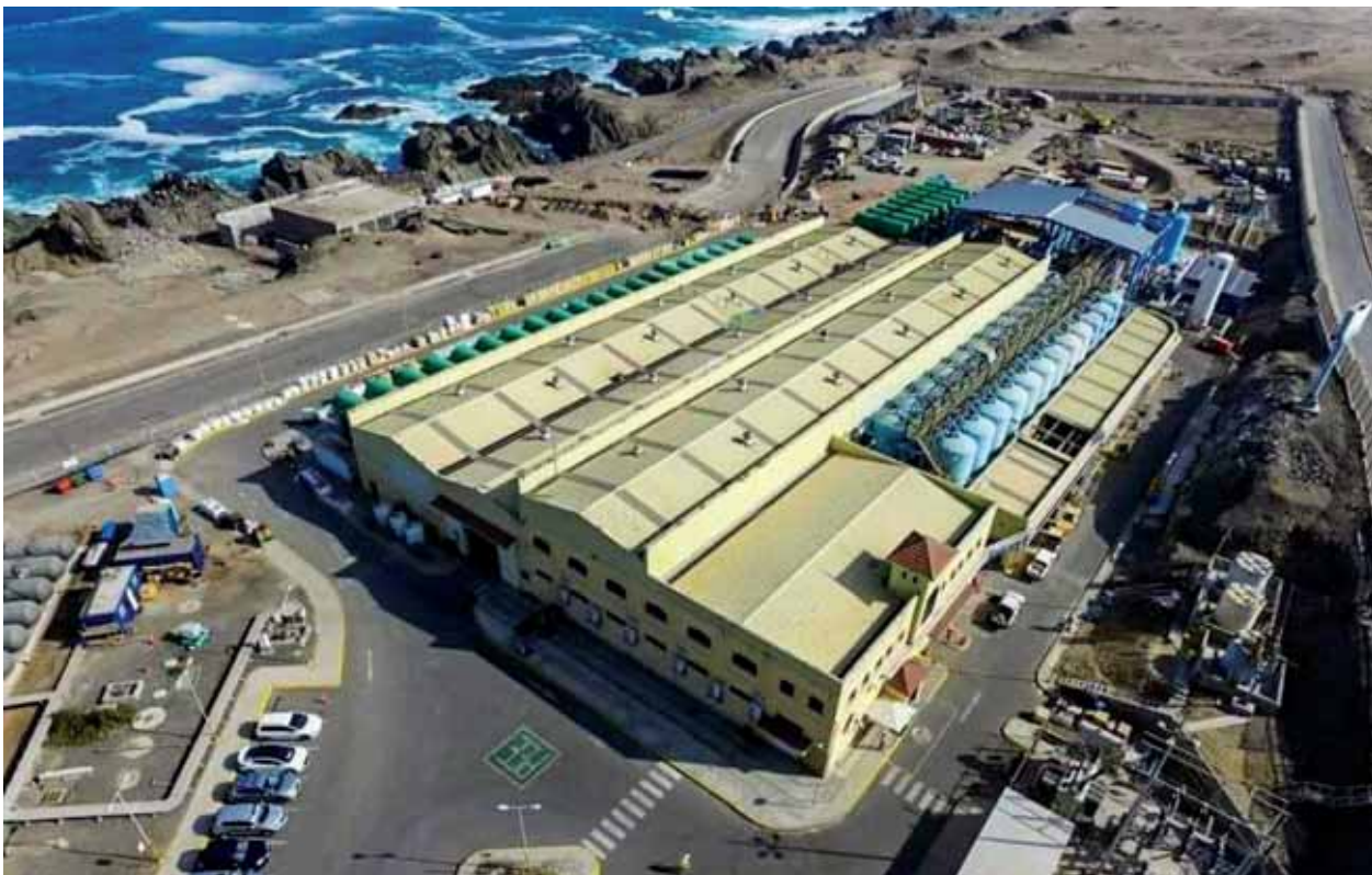
Planta Desaladora, ubicada en el sector La Chimba
