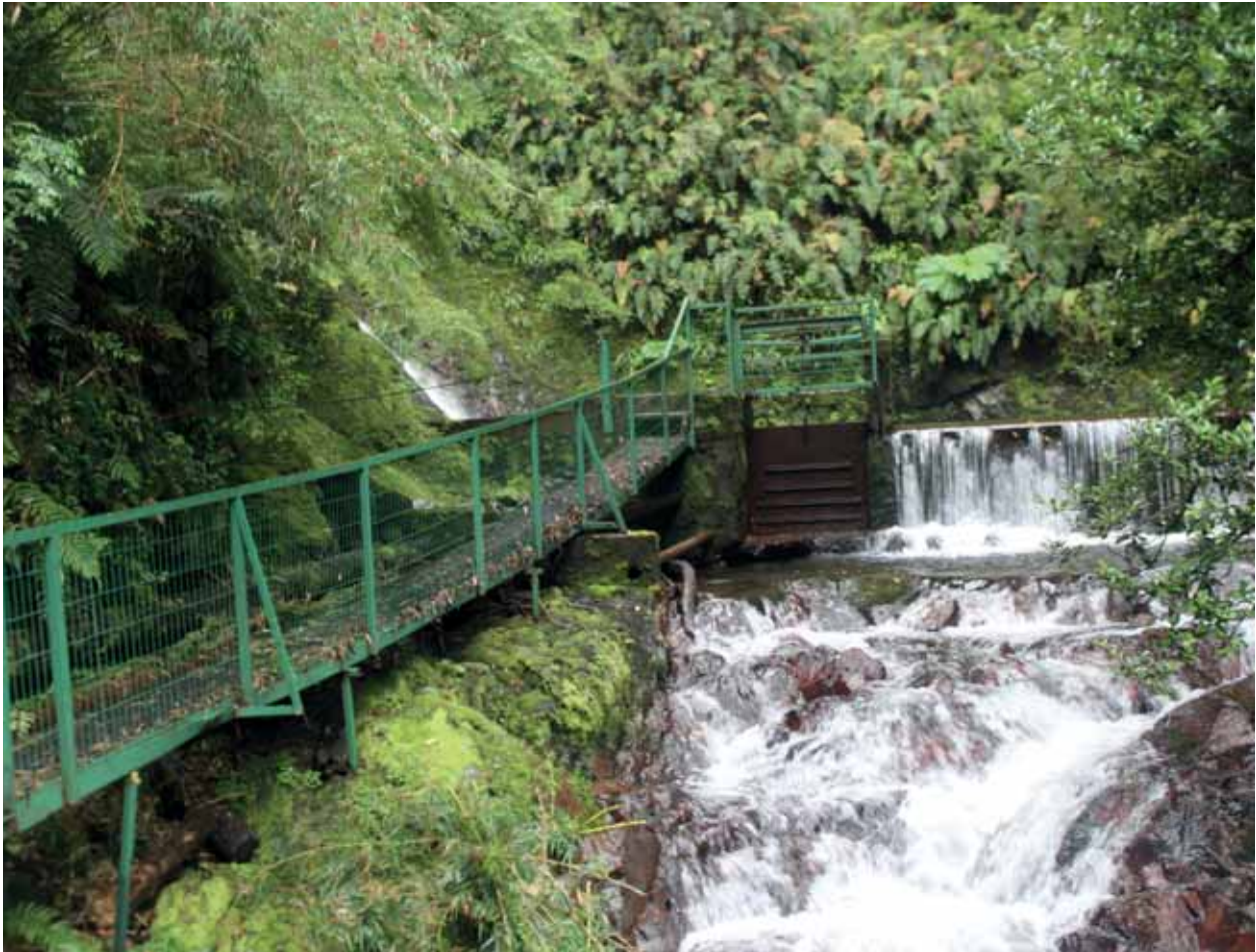
Captación Puerto Cisnes
