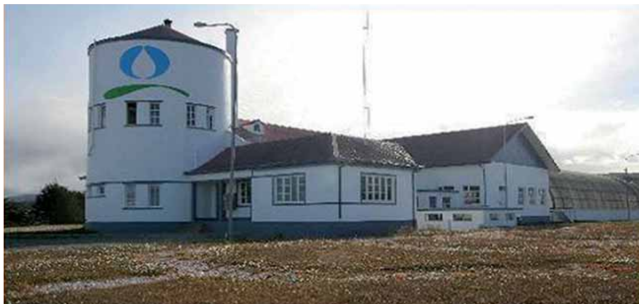
Centro de control operacional de Aguas Magallanes.
