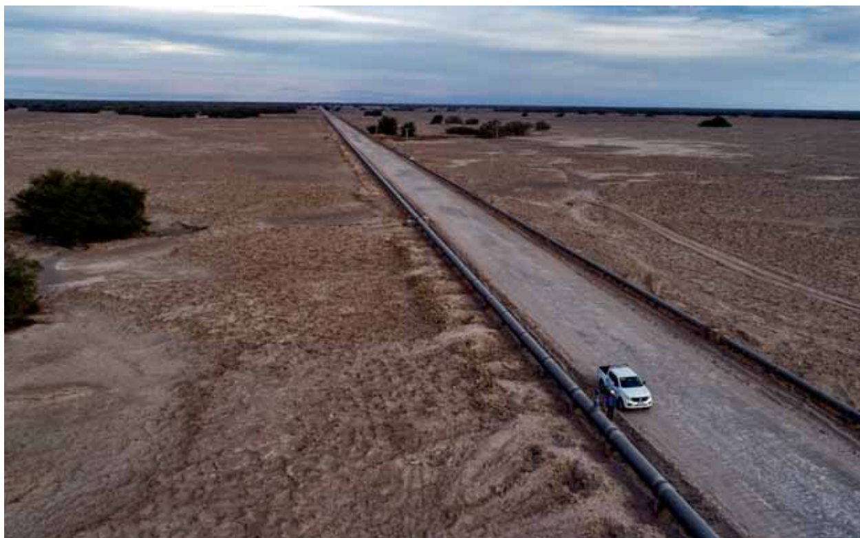
Aducción de agua potable de Aguas del Altiplano en la Pampa del Tamarugal
