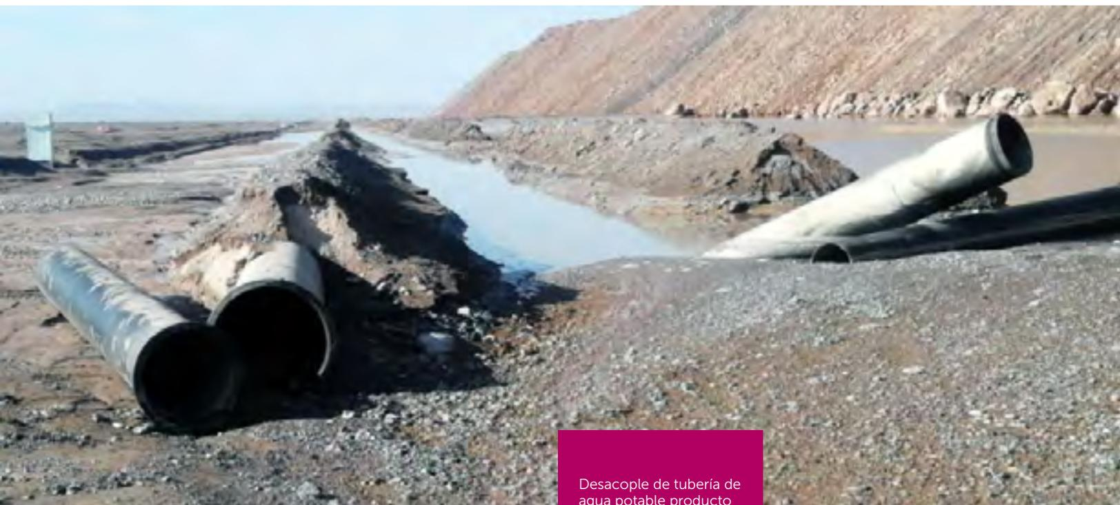
Desacople de tubería de agua potable producto de precipitaciones por sistema frontal y posterior remoción en masa.
